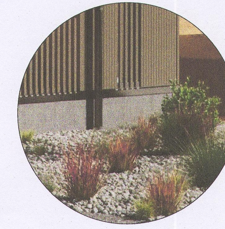
8.Fassadensockel Kupferblech gekantet vorfabriziertes Betonelement Schalungstyp 4 betongrau
