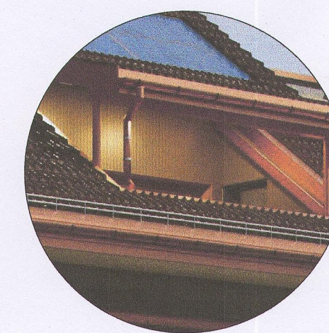
18.Loggia/Gaube Untersicht 3 Schichtplatte deckend gestrichen RAL 9016
