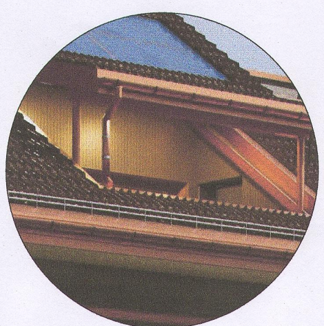
16.Loggia/Gaube Untersicht 3 Schichtplatte deckend gestrichen RAL 9016
