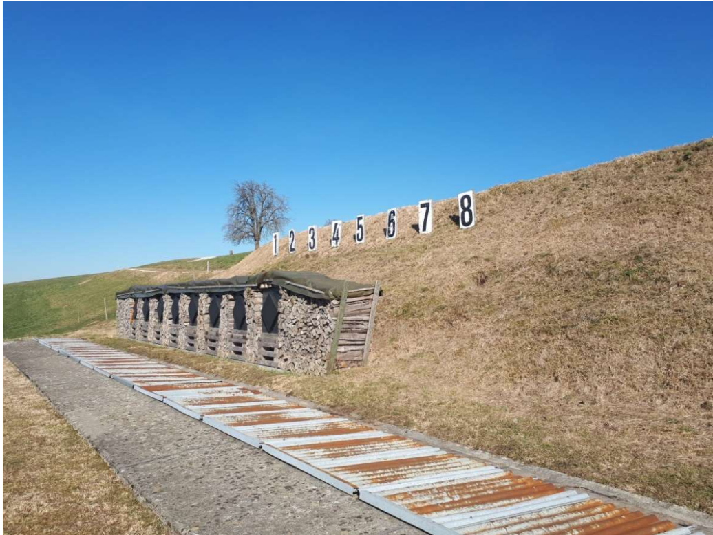
Nr. 1: Blick nordöstlich Richtung Kugelfang. (Porta AG, 27.02.2019)
